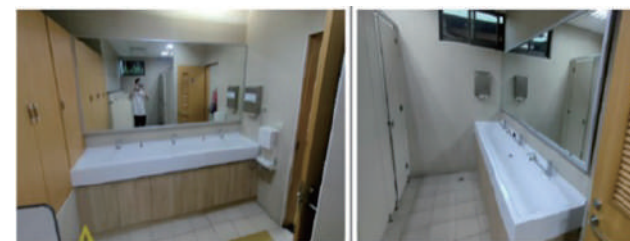
北興廠1F廁所洗手台改善
